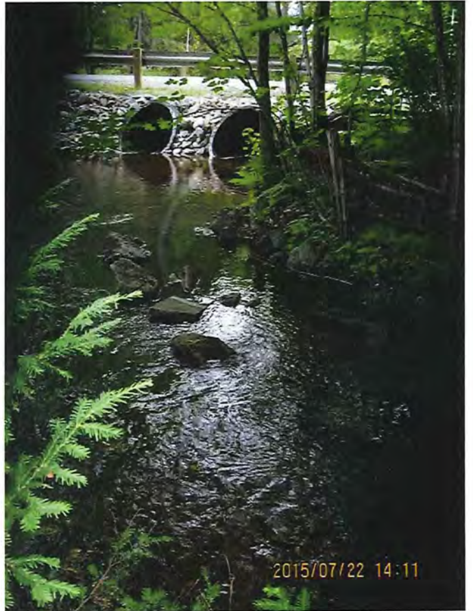
IMG_0903.jpg : aval du barrage vers Lac Caron
