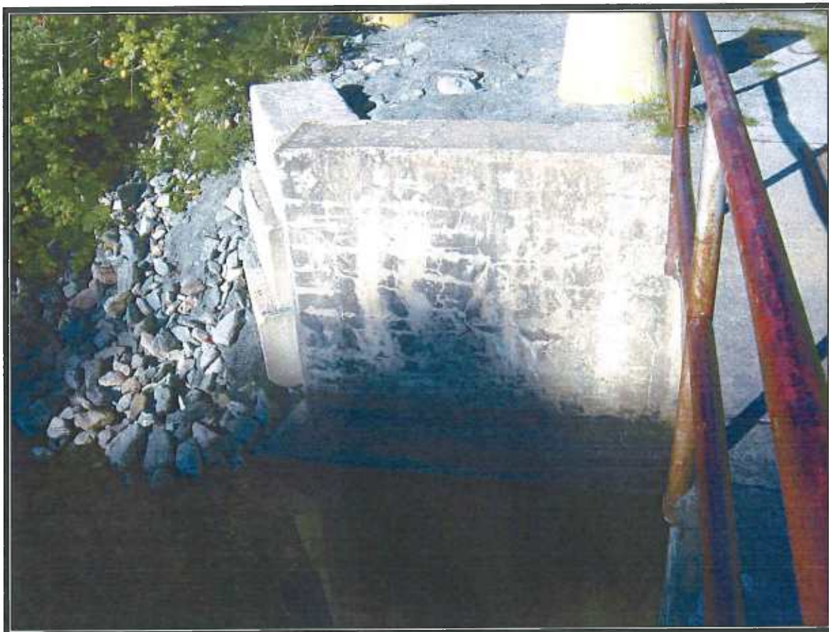
Photographie 1 : Mur de soutènement en rive gauche – côté amont
